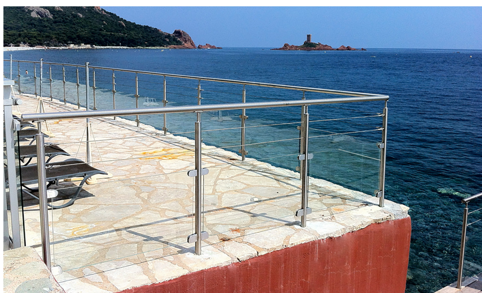
Sonderanfertigung: Geländerpfosten mit Glasklemmen und Drahtseilsystem; Sonnenterrasse in Frankreich
